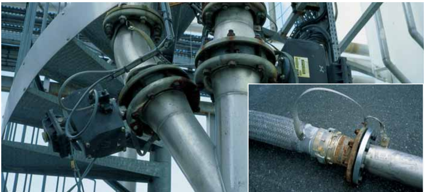
Photo 3.2 Shunts électriques assurant la continuité électrostatique d'une canalisation dans laquelle circule un solvant.
