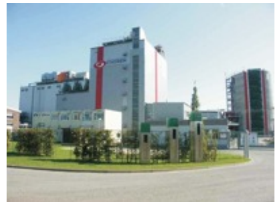
Usine pilote de Choren à Freiberg
