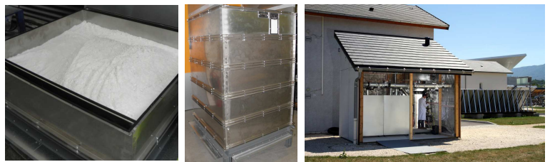
Remplissage, assemblage et installation sur site des réacteurs
