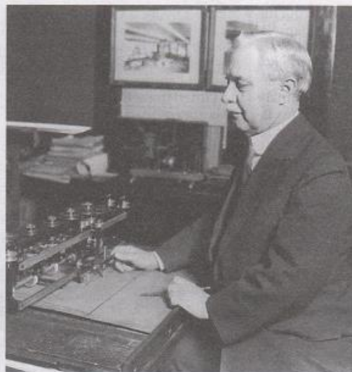
Dayton Miller à la Case School, utilisant un analyseur harmonique Henrici. Cet instrument d'abord destiné à l'acoustique, servira ensuite à interpréter les données interférométriques.
